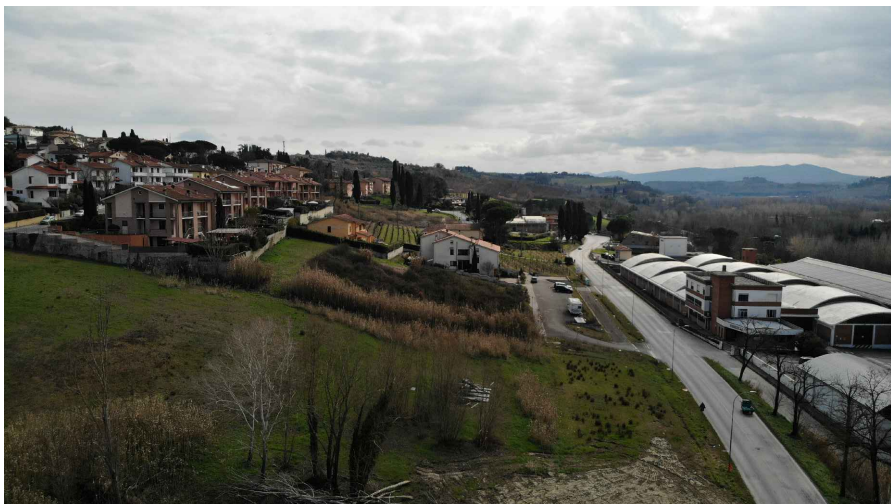
Vista da Via L. Da Vinci
