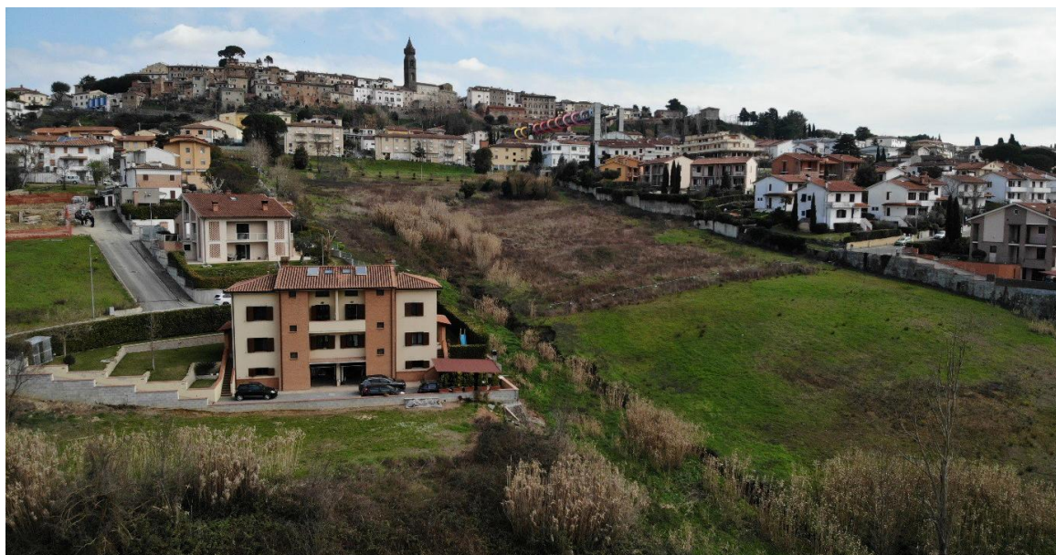
Vista dell'area oggetto di intervento
