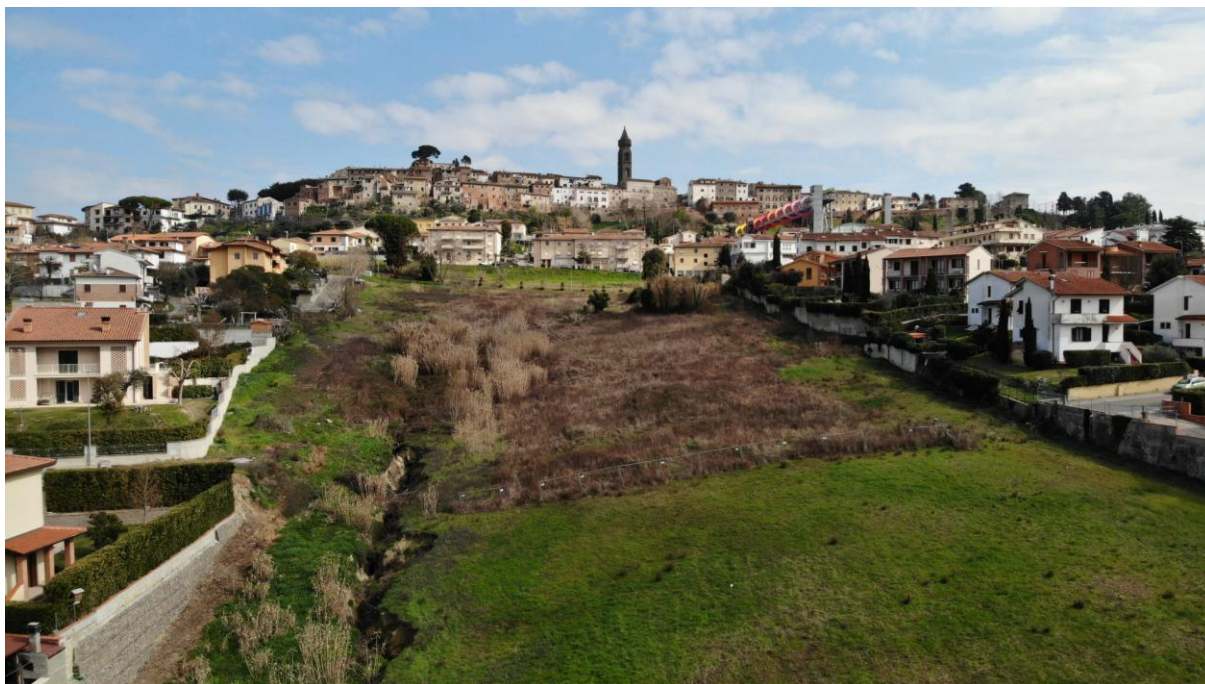
Vista area di intervento dal drone (a destra Via Leonardo Da Vinci)
