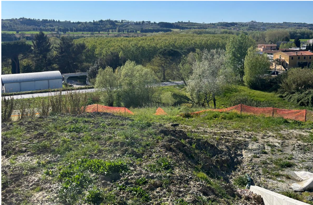
Area di intervento a valle, sullo sfondo Viale Gramsci – Sp64 – e l'area ex Toncelli
