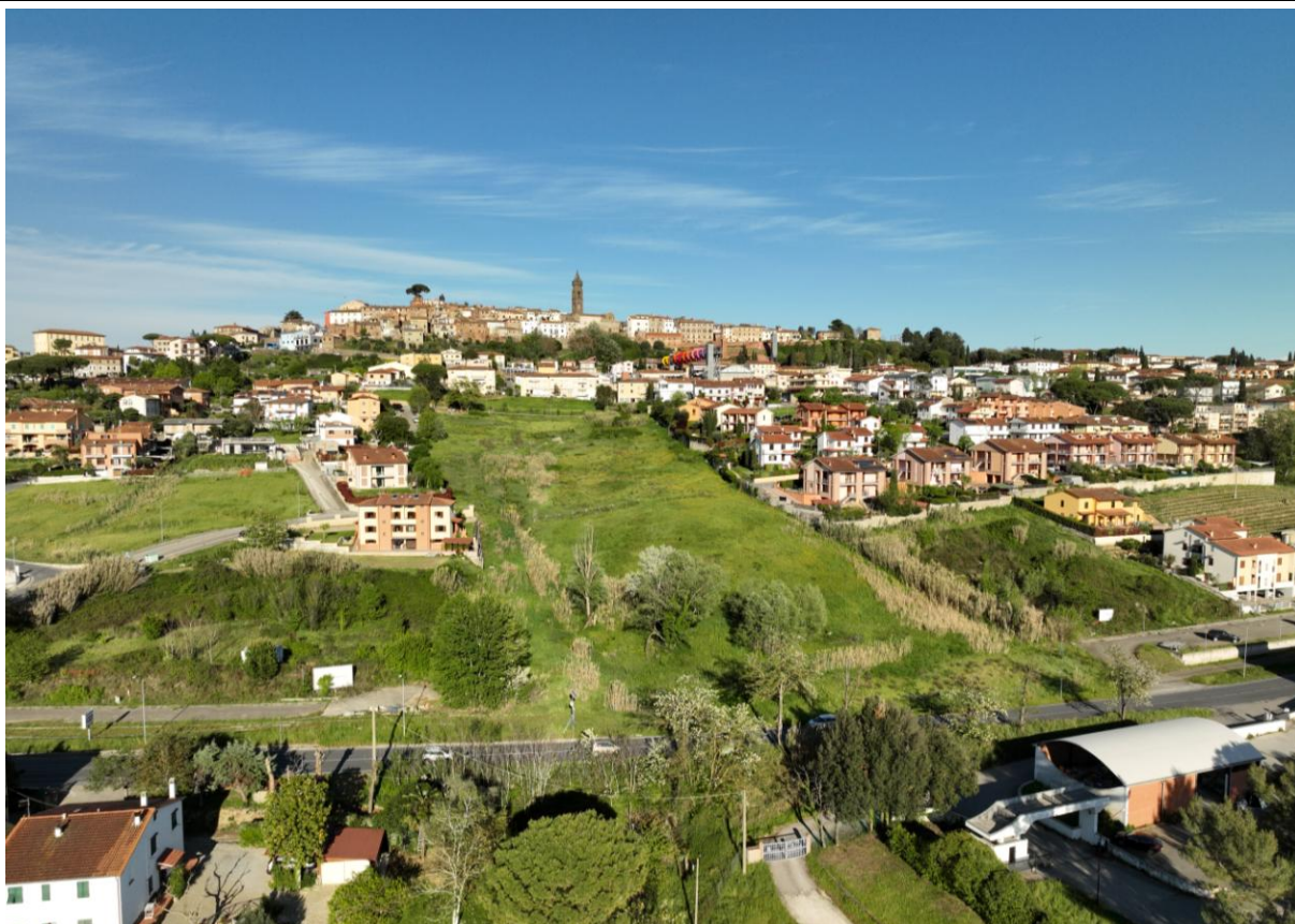
Vista area di intervento dal drone (in basso Viale Gramsci)
