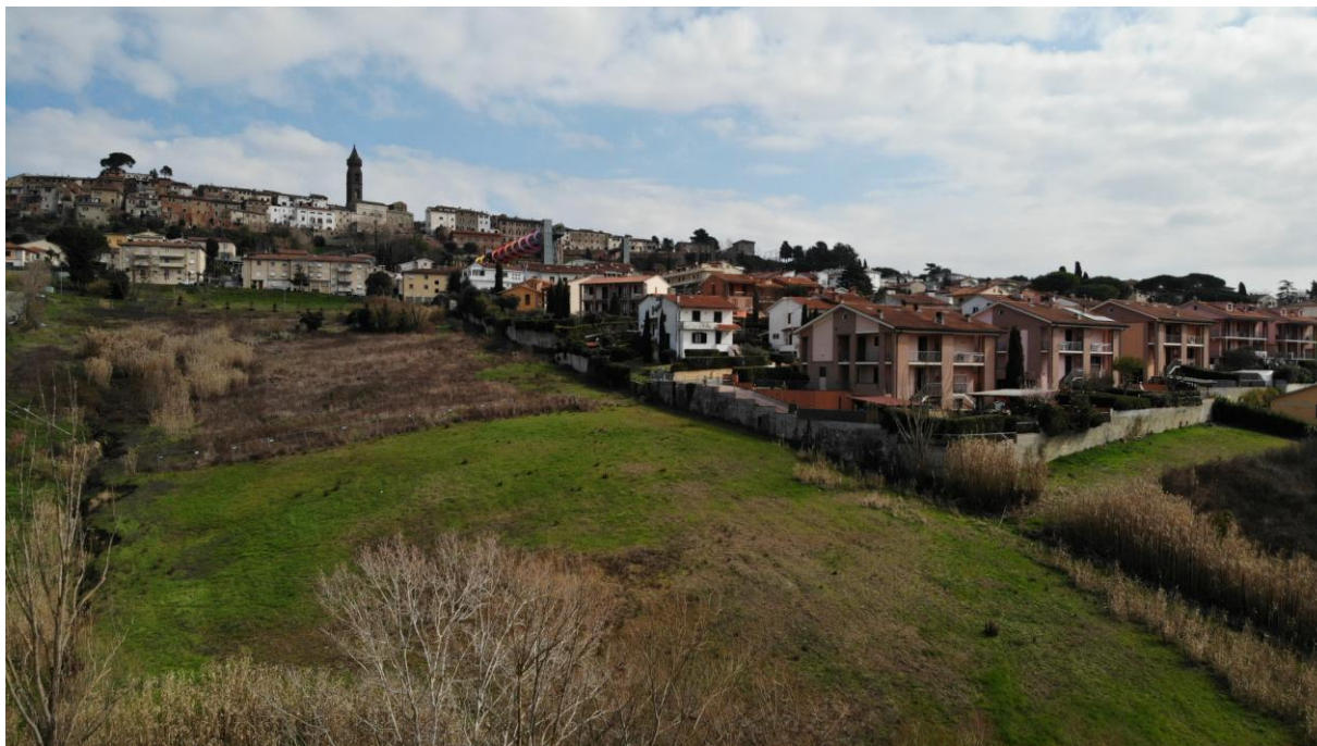
Vista area di intervento dal drone
