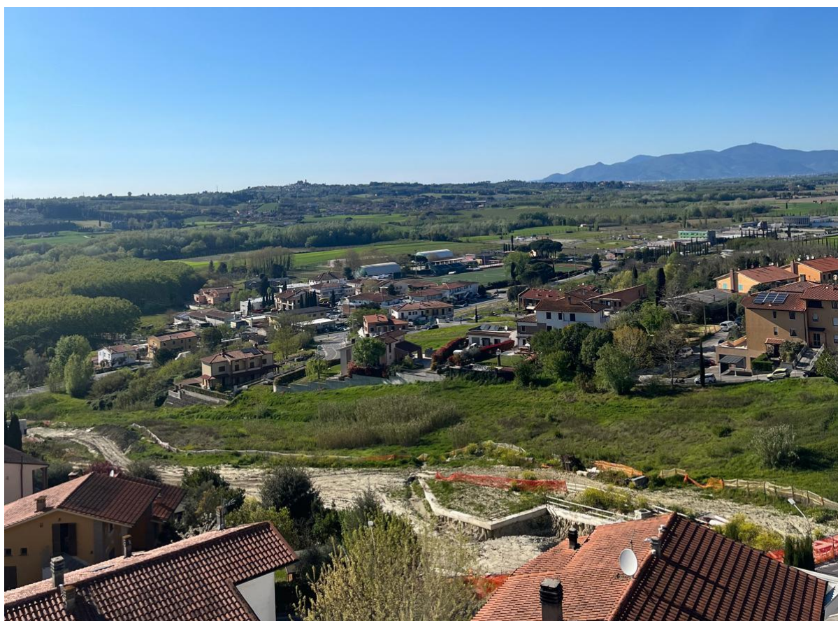
Vista dell'area di intervento con il cantiere del lotto funzionale 1
