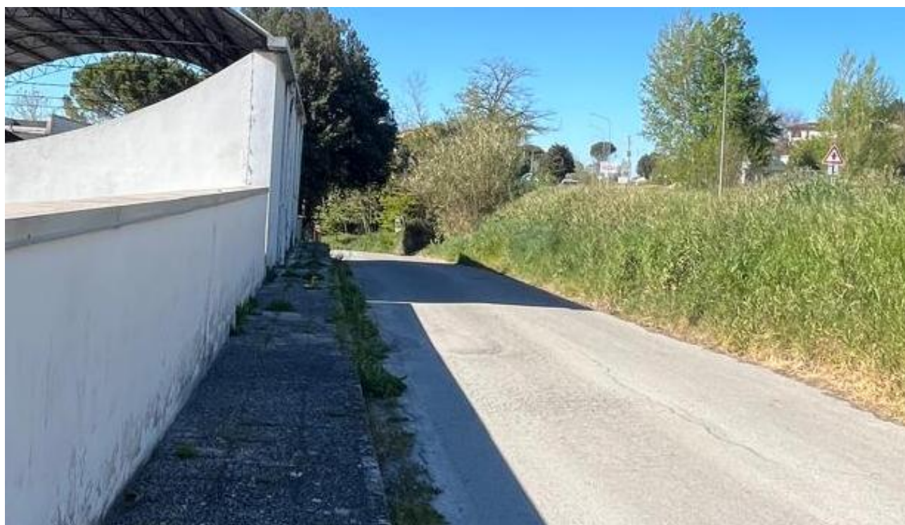
Area ex Toncelli: sullo sfondo futura uscita tunnel sottopasso Viale Gramsci – Sp64
