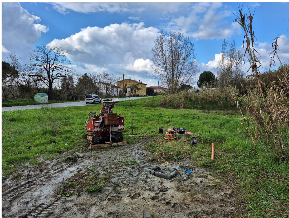
Figura 1: Indagine sismica Down Hole
